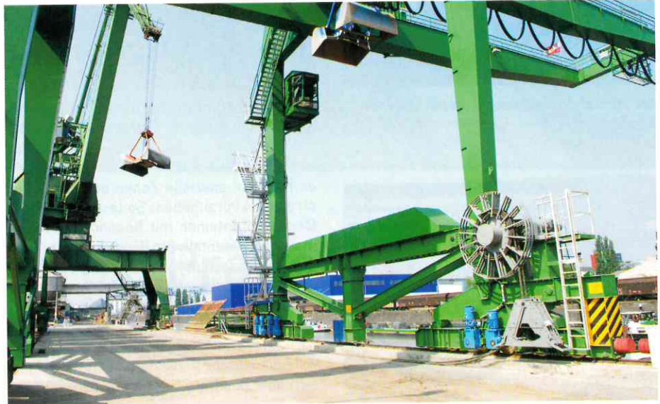
Hafenkranen sind ein typischer Einsatzort für Motorleitungstrommeln. Oft sind individuelle Lösungen gefragt für die konkreten Anforderungen der jeweiligen Gegebenheiten.
